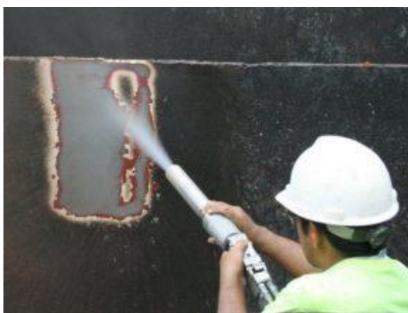
Rysunek 7. Oczyszczanie strumieniowo – ściernie podłoża metalowego [14]
